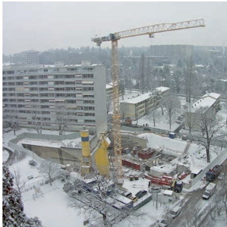
Hiver 2015: Chantier Vieusseux 23 à 27
