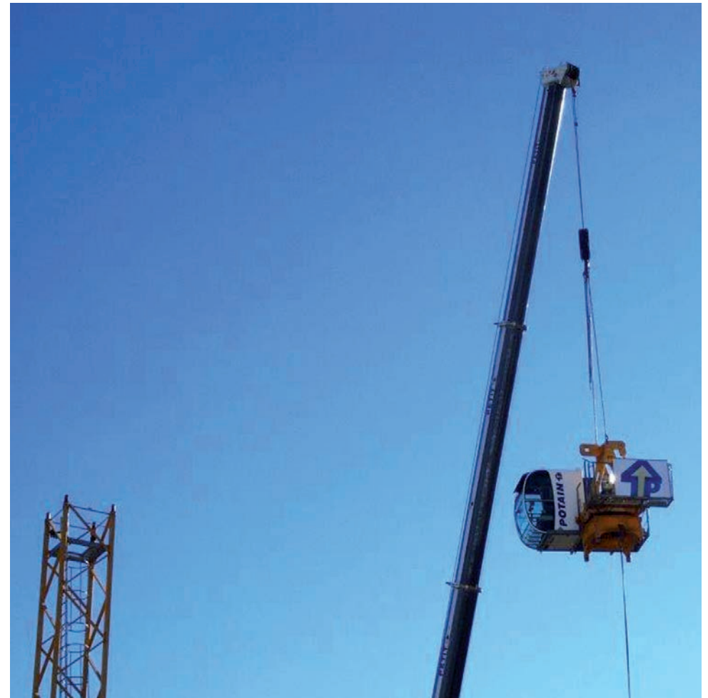
Montage «aérien» de la grue
